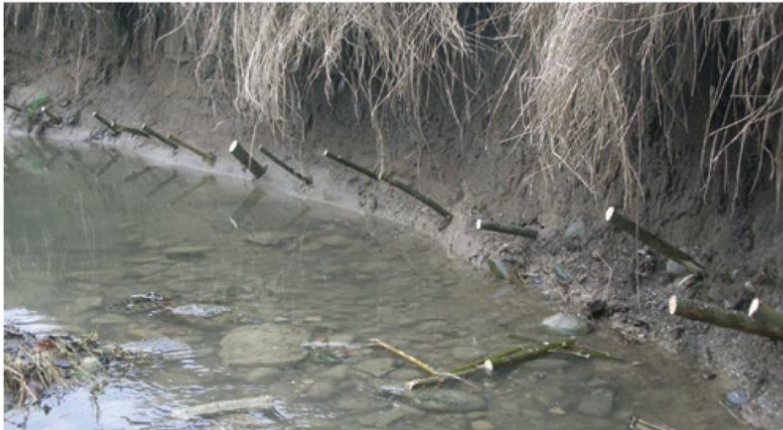
Steckhölzer entlang der Uferline eingebaut für späteren Erosionsschutz. (Foto: R. Herrigel)
